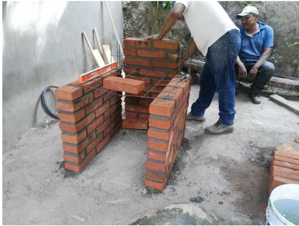
Muro de tabique rojo de 7 x 14 x 28 cm, asentado con mezcla cemento-arena 1:4, acabado aparente, incluye: materiales, mano de obra, equipo, herramienta y todo lo necesario para su correcta ejecución.
