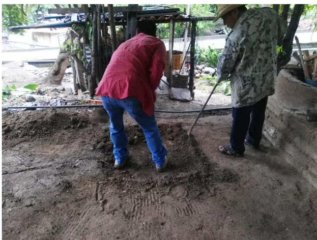
Excavación con herramienta manual, en material "B", en seco incluye: afloje, extracción, amacice o limpieza de plantilla y taludes, carga a camión o a un lado de la zanja, acarreo a 10 m y conservación de 0.00 a 2.00 de profundidad.
