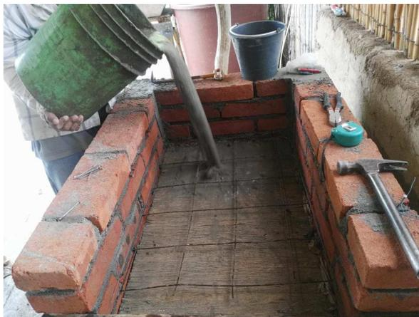
Losa de 5 cm acabado común, armado con malla 6 x 6/10-10, de concreto  $f'c = 200 \text{ kg/cm}^2$ , incluye: suministro de materiales, acarreo, nivelación, cimbrado de fronteras, mano de obra, equipo y herramienta.
