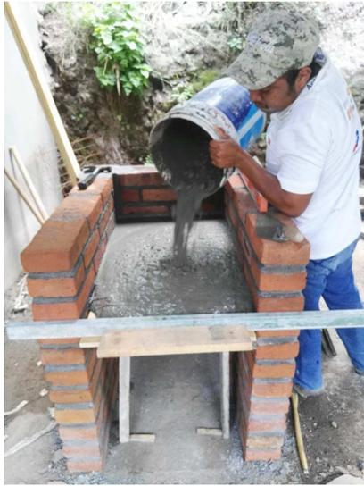
Losa de 5 cm acabado común, armado con malla 6 x 6/10-10, de concreto  $f'c = 200 \text{ kg/cm}^2$ , incluye: suministro de materiales, acarreo, nivelación, cimbrado de fronteras, mano de obra, equipo y herramienta.
