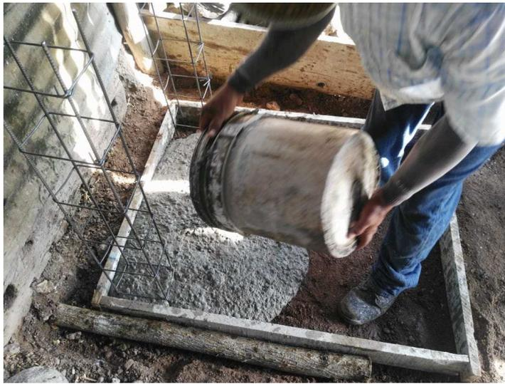
Firme de 10 cm acabado común, de concreto  $f'c = 150 \text{ kg/cm}^2$ , incluye suministro de materiales, acarreo, nivelación, cimbrado de fronteras, mano de obra, equipo y herramienta.
