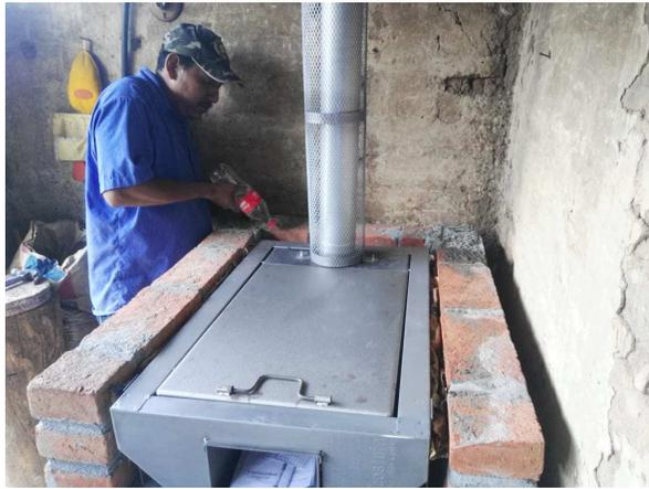
Suministro y colocación de estufa de lamina galvanizada cal. 22, incluye: nivelación, fijación, mano de obra y herramienta.
