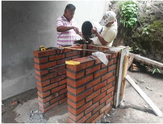
Castillo en estructura a base de armex de 0.15 x 0.20 m. de concreto hecho en obra, de  $f'c = 200 \text{ kg/cm}^2$ , acabado aparente (con chaflan), incluye: suministro de materiales, acarreo, elevaciones, cortes, traslapes, desperdicios, habilitado, cimbrado, descimbrado, limpieza, mano de obra, equipo y herramienta.
